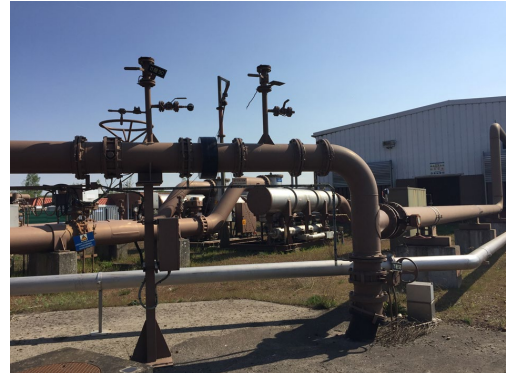
Figure 2 - puits 7b d'Avion
